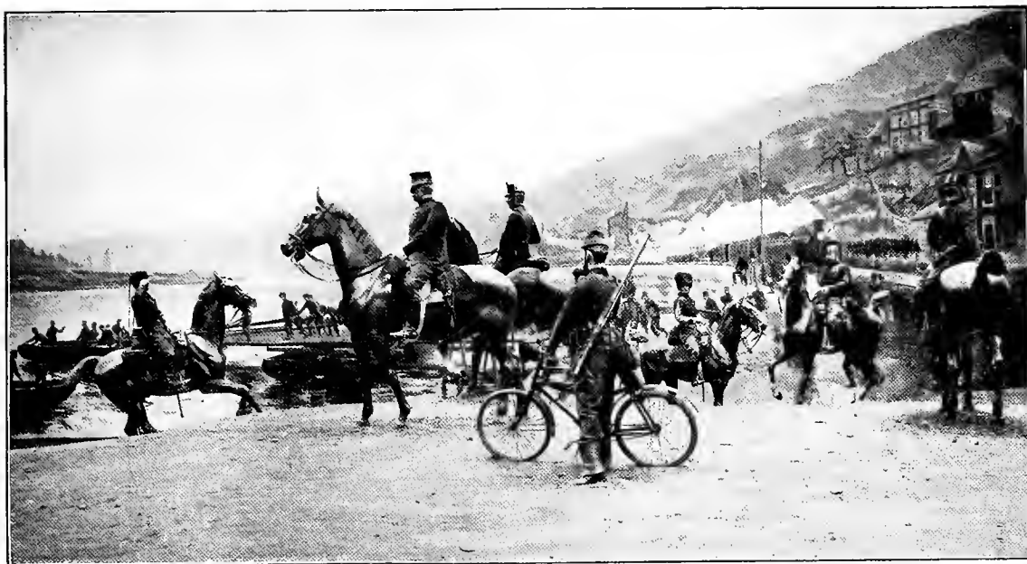
CONSTRUCTION D'UN PONT MILITAIRE A JUPILLE.
